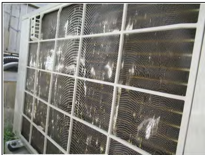
fins damaged
